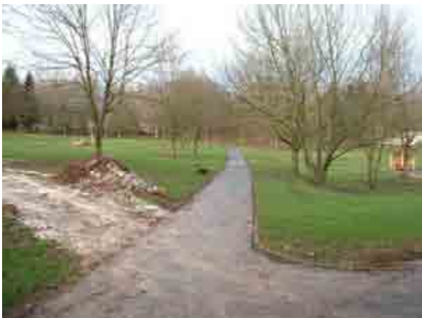
Entsiegelung Parkweg mit neuer Wegführung
